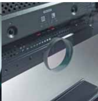
Отверстие для прокладки кабеля
